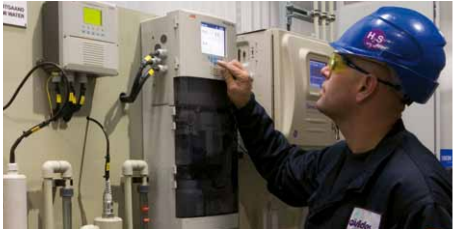
Meetbord bij het uitgaand demiwater met analysers voor onder andere geleidbaarheid, TOC en pH.
