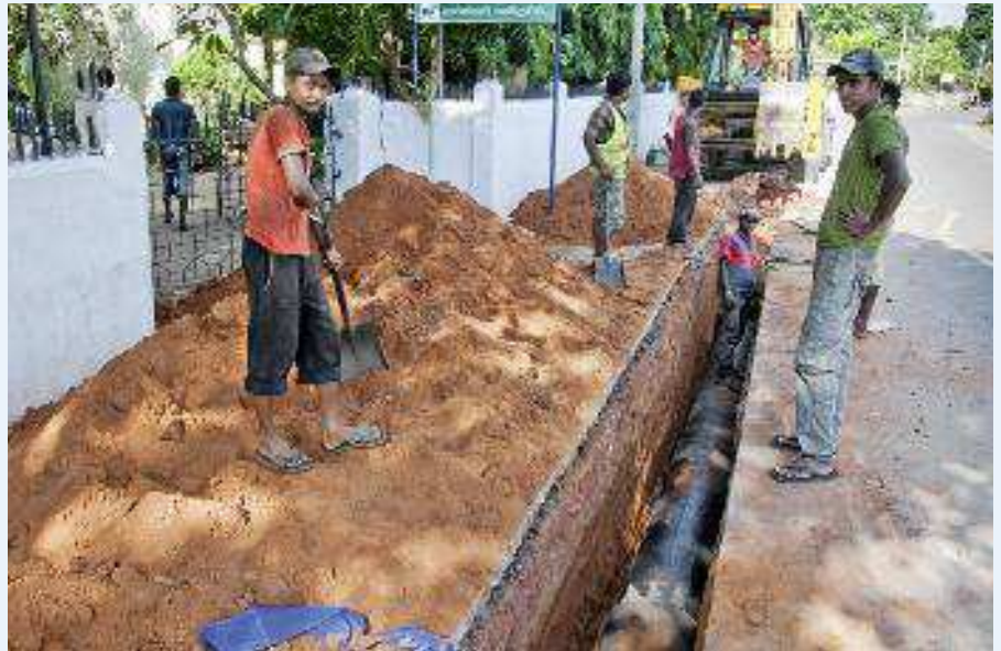
De aanleg van distributieleidingen wordt inmiddels planmatig en gecontroleerd uitgevoerd.
